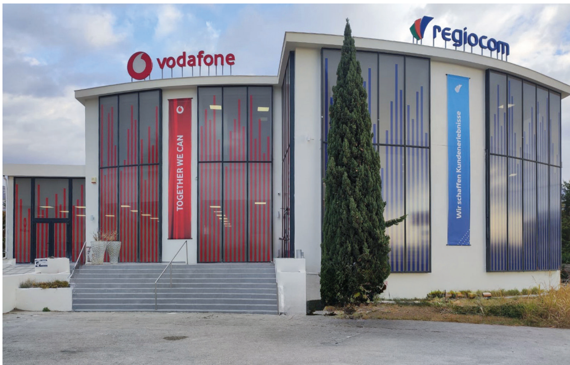
Εικόνα: Το νέο τηλεφωνικό κέντρο της regiocom και της Vodafone
